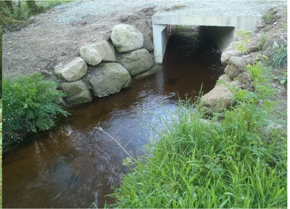
Pose d'un pont cadre et d'un Ecopal au lieu-dit « Bonne Chère »
