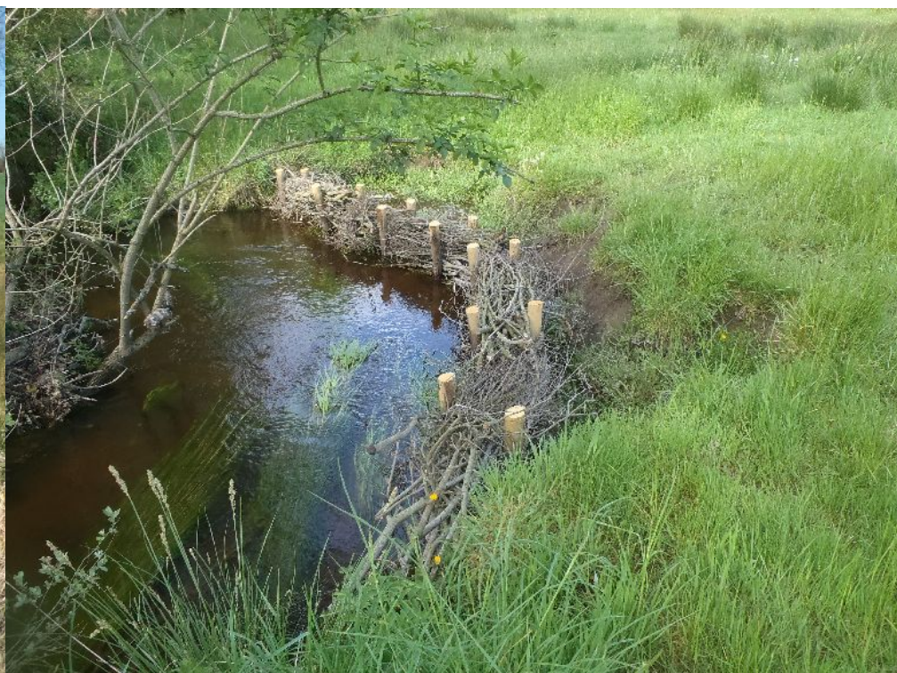
Réalisations de fascines
