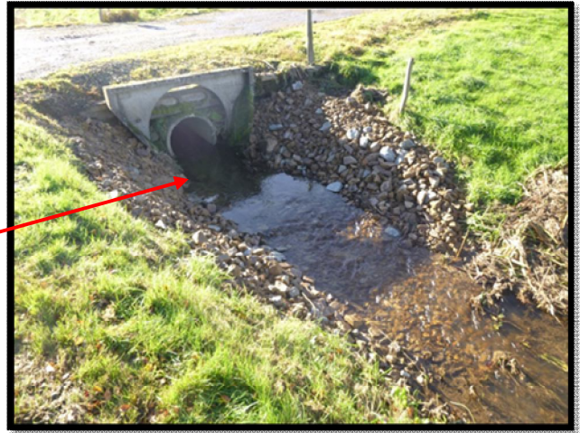
Vue aval (après travaux)
