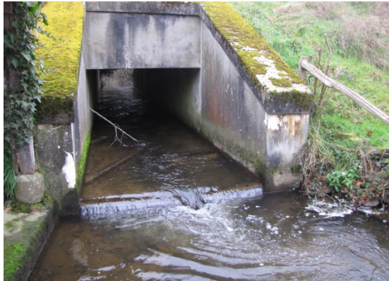
Aménagement de barrettes off-set sur le pont du Chandon et sur le lavoir de Fontenai-les-Louvets
