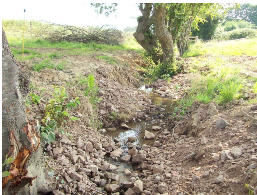
Aperçu d'une portion de cours d'eau rechargée
