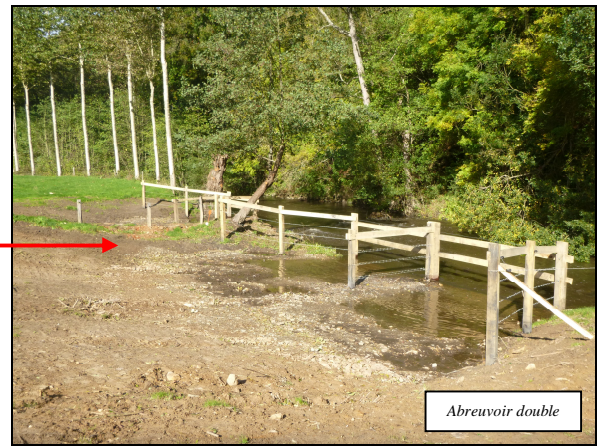
Zone aménagée (après travaux)
