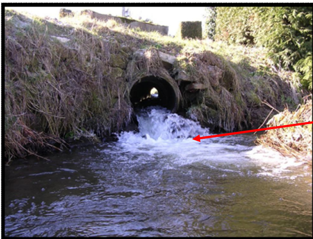
Vue aval (avant travaux)
