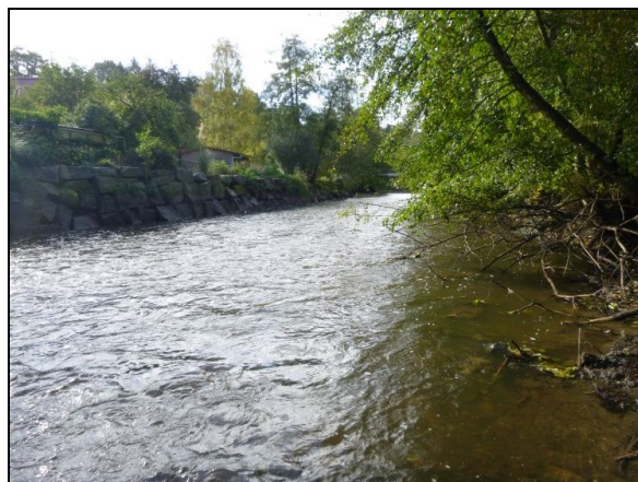
Ligne d'eau et faciès d'écoulement à l'amont (après travaux)
