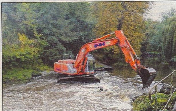
Les travaux se sont faits en deux semaines.
