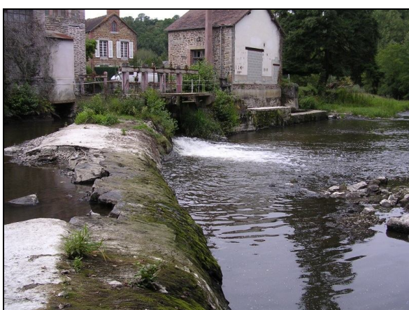
Seuil transversal et vannage (avant travaux)
