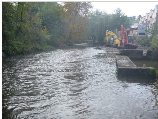
Vue aval (après travaux)
