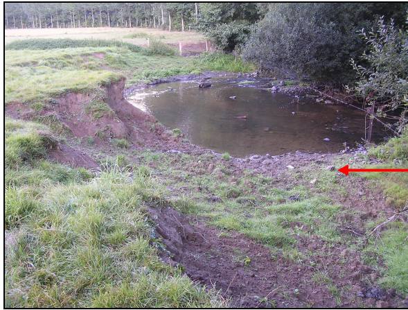
Zone piétinée (avant travaux)
