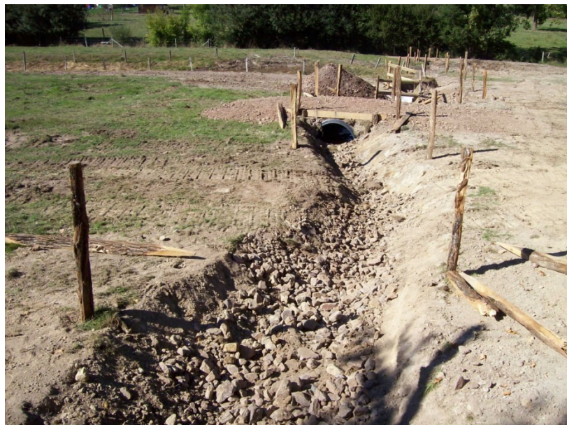
Création du lit de dérivation
