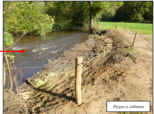
Zone aménagée (après travaux)
