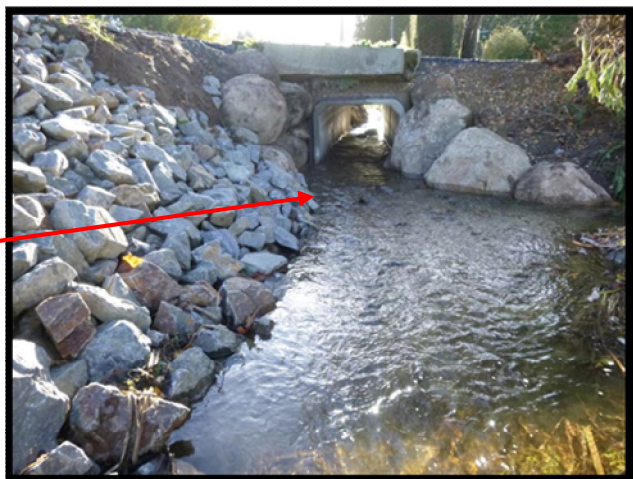
Vue aval (après travaux)
