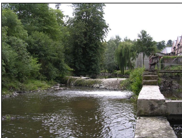
Vue aval (avant travaux)
