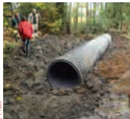
Pose de l'Ecopal (pendant les travaux le ruisseau est détourné)
