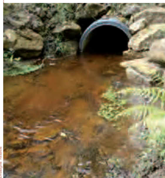
Après les travaux, le cours d'eau reprend ses droits.
