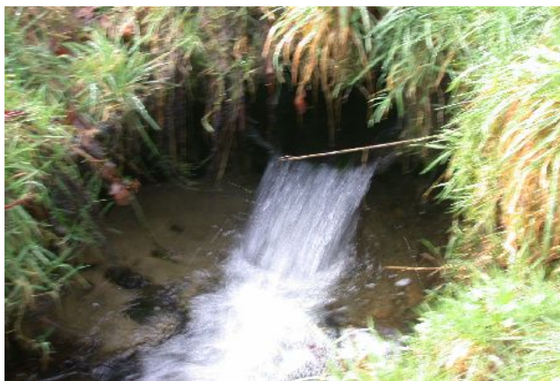
Un obstacle infranchissable pour la truite fario : une buse sur le Hoaz Glaz
