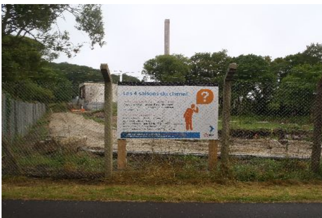
« Assainissement » du chenal de la centrale nucléaire de Brennilis
