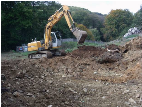
Figure 1 et 2 : terrassement du bâtiment de production
