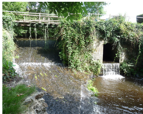
Seuil du lieu dit la Forge
