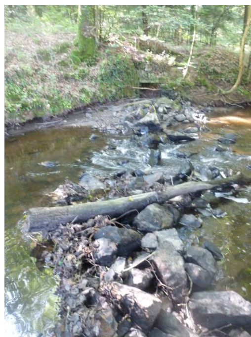
Seuil en partie démantelé
