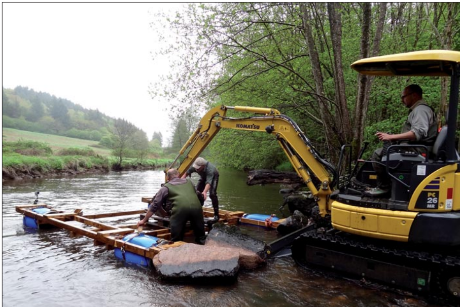
[4] Transport des blocs de granit de l'ancien seuil de la Côte Cadoux par radeau
