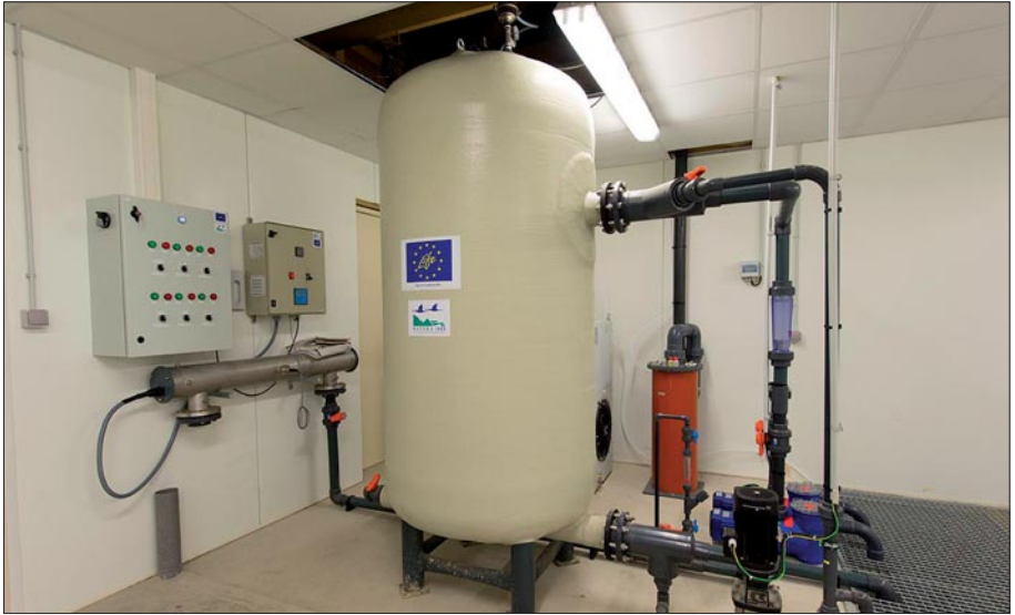
[9] Le système de traitement des effluents (ozoneur et filtre ultra-violet)
