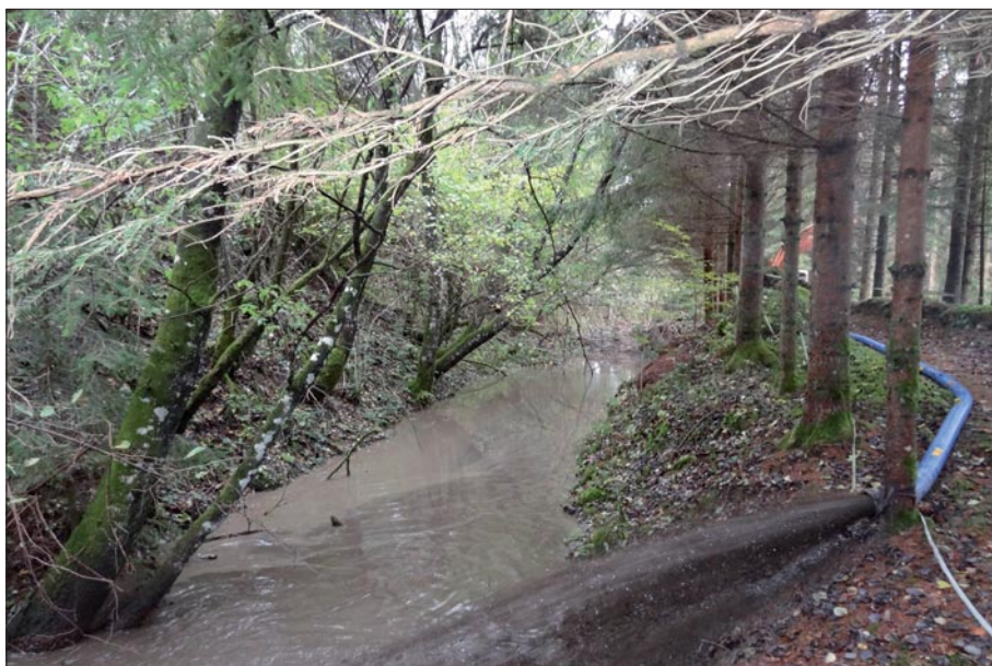
[6] Rejet des vases du fond de l'étang de Chailloux dans des bassins de décantation
