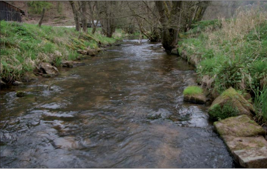
[7] L'enrochement des berges conduit à un rétrécissement de la rivière.
