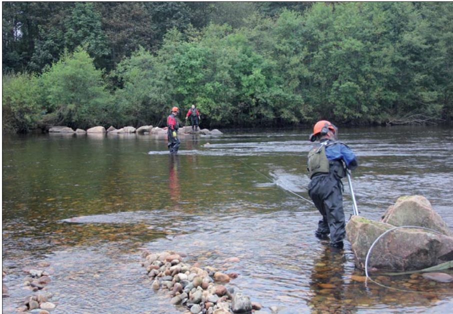
[3] Démantèlement des déflecteurs de courant à l'aide d'un treuil manuel
