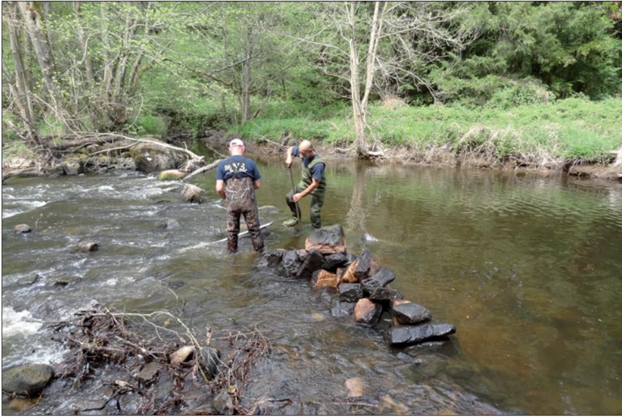
[3] Démontage du seuil de la Côte Cadoux à la main
