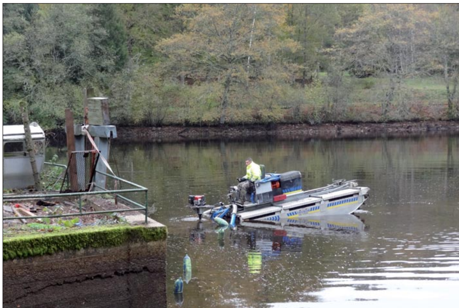
[5] Pompage des vases au fond de l'étang Chailloux avec une suceuse sur barge amphibie
