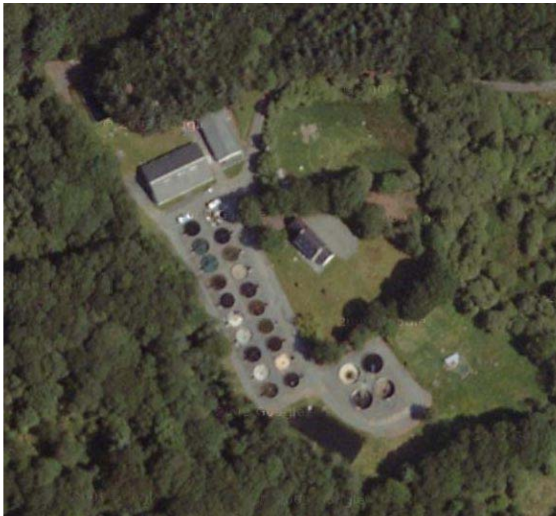
VUE AERIENNE DU SITE A L'ETAT ACTUEL
