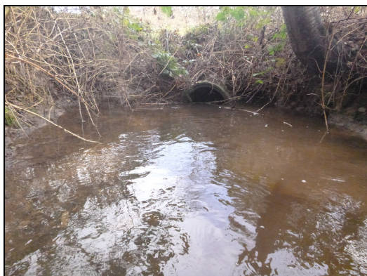
Vue aval (amont travaux)
