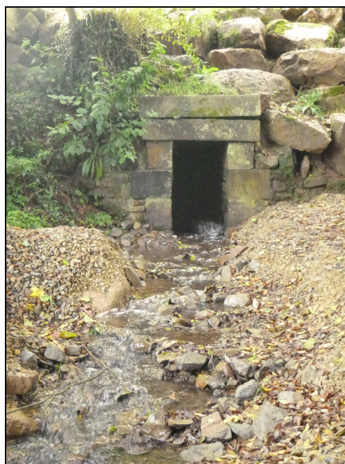
Vue aval (après travaux)
