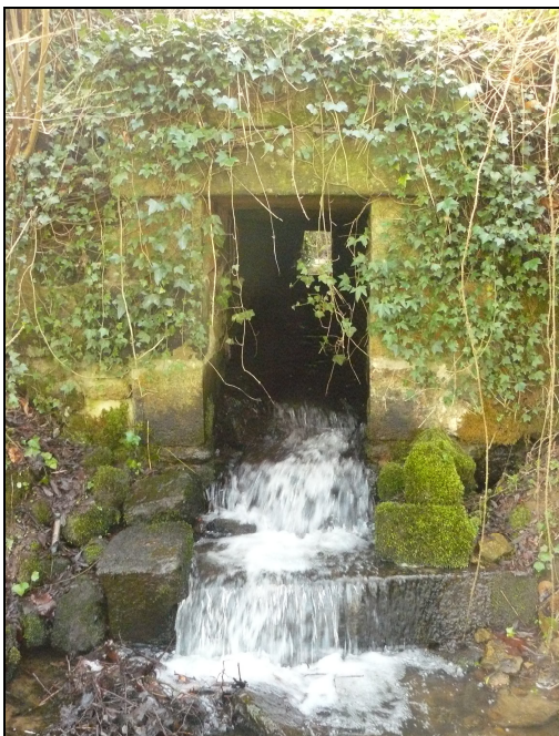
Vue aval (avant travaux)
