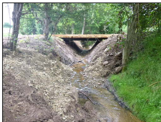
Vue aval (après travaux)
