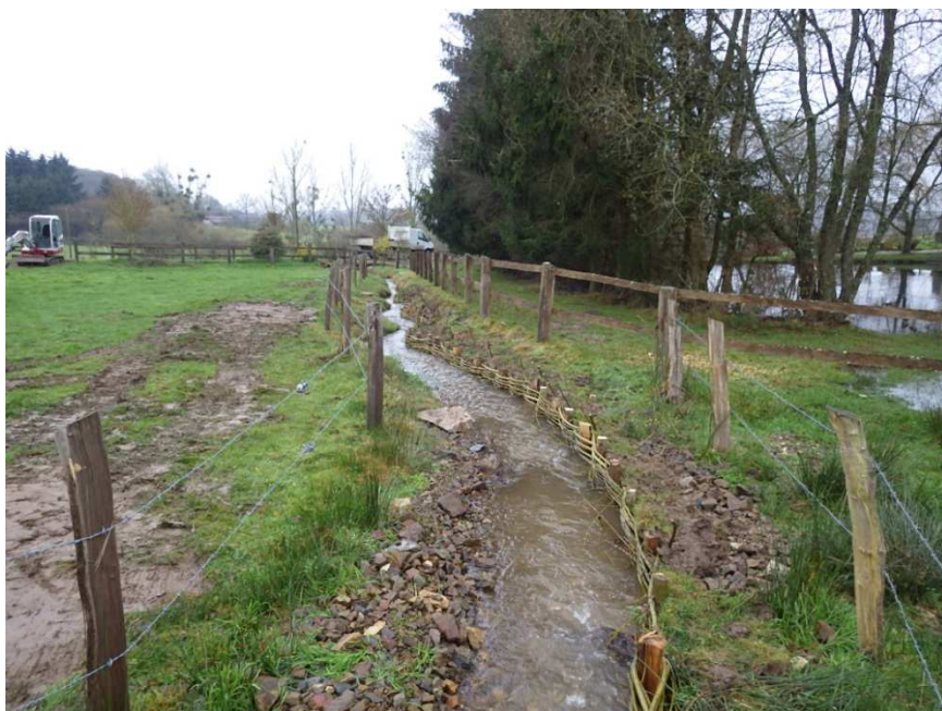
Aménagement d'un tressage dans la portion concave du ruisseau située en bordure d'étang
