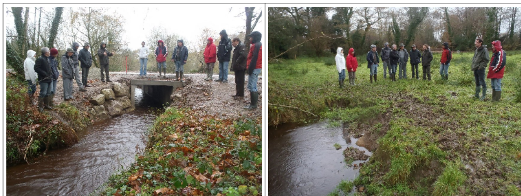
Visite des travaux réalisés (pont-cadre) ou à réaliser (aménagement d'abreuvoir) par le CTMA. Photos Pierre-Yves Pasco
